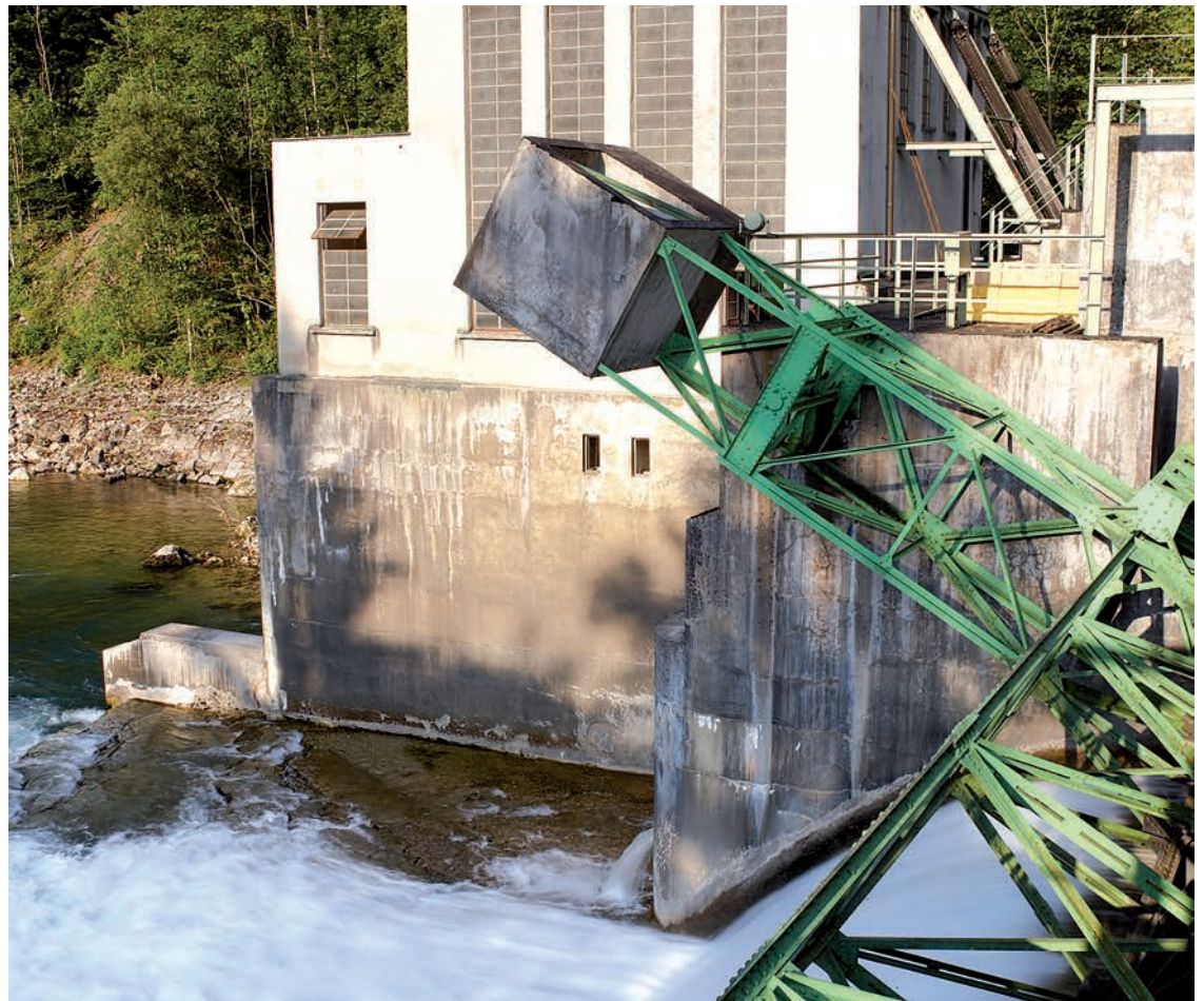
Nachhaltigkeit wird mit einem eigenen Kleinwasserkraftwerk und 100 % CO 2 -neutraler Fertigung auf allen Ebenen groß geschrieben. Foto: Riess
